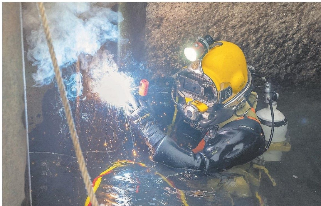
Im Tosbecken des Neckar-Stauwehrs schweißt Hadis Saric eine Wasserhaltung für den Bau der neuen „Radbrücke Ost“.
